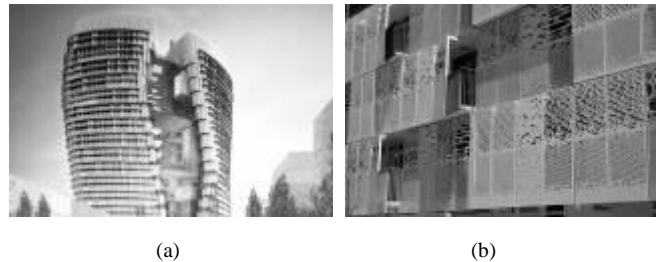
Gambar 2. (a) Panel surya sebagai elemen estetika bangunan, (b) Perforated metal untuk mengurangi beban penerimaan panas pada bangunan (Sumber : www.archdaily.com )
