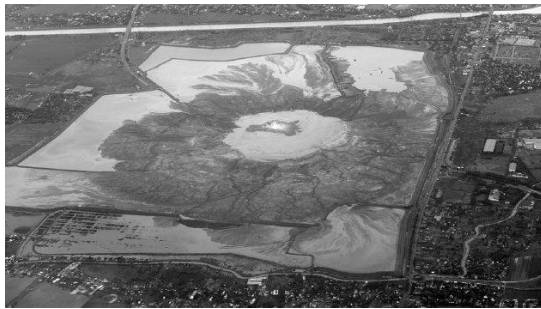
Gambar 1.1 : Kondisi kolam lumpur saat ini
