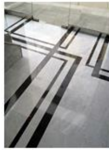
Lantai di area semi public seperti area lobi, lounge, dan fasilitas lain menggunakan material granit yang glossy
