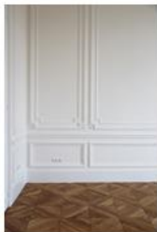
aksen-aksen profile gypsum di beberapa ruang
