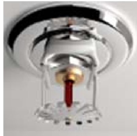
Gambar 15. Sprinkler yang Dipasang pada Ceiling Beberapa Titik
