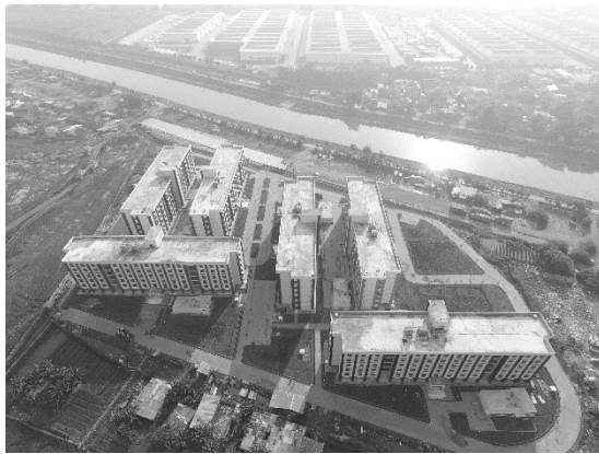
Gambar 4. Contoh penyusunan rusun Rawabek, Jakarta. (sumber: Dokumentasi Direktorat Rumah Susun)
