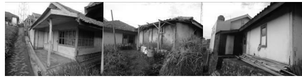
Gambar 4. Rumah dengan Kondisi Tidak Layak
