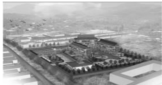
Gambar 1. Objek bangunan. (Sumber: Dokumentasi Pribadi)
