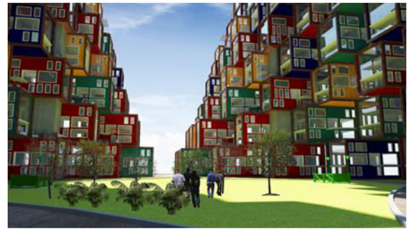
Gambar 8. Suasana Bangunan. Sumber: Dokumentasi Pribadi
