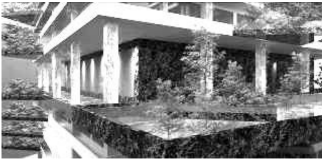
Gambar 20. Green dan water wall.
