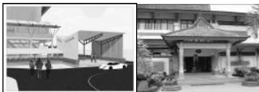
Gambar 5. Entrance Sesudah dan Sebelum.
