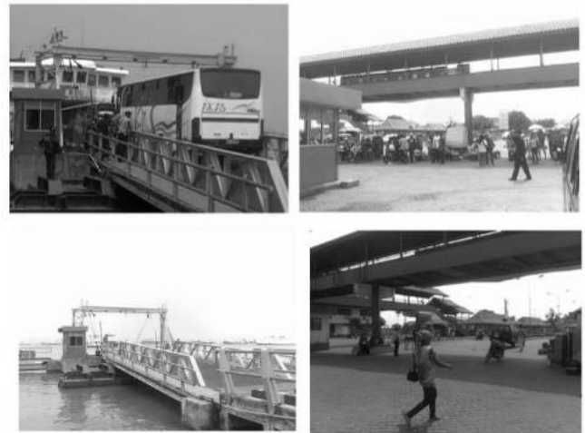
Gambar 1. Kondisi eksisting jetty dan area antrian pelabuhan kamal
