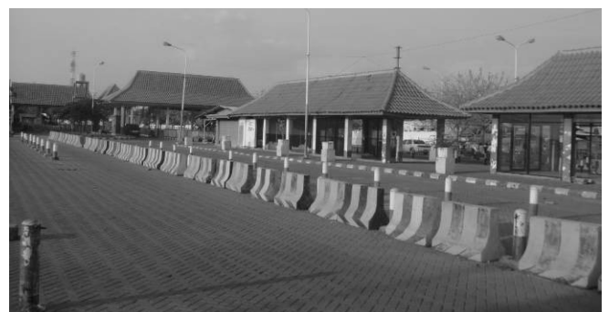
Gambar 3. Kondisi eksisting area berjualan di Pelabuhan Kamal
