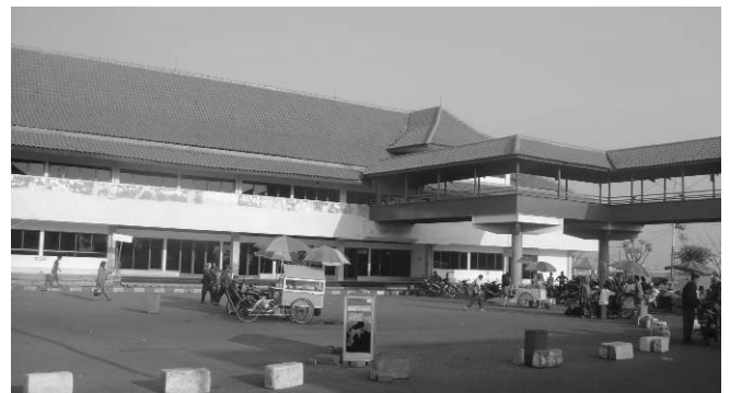
Gambar 2. Kondisi eksisting terminal Pelabuhan Kamal
