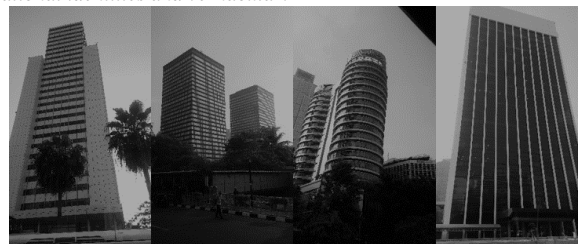
Gambar 2. Gedung Perkantoran di Daerah Jakarta, Indonesia.
