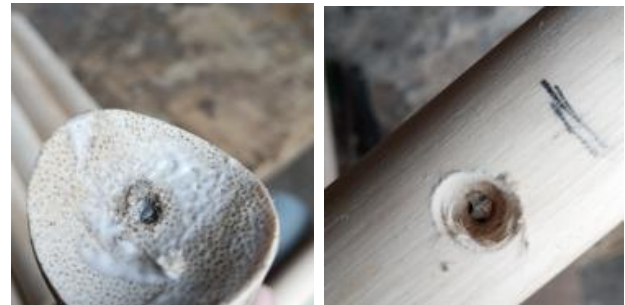
Gambar 6. Percobaan pemasangan baut.
