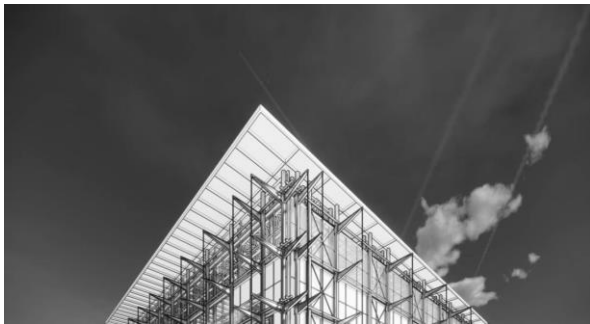
Gambar 12. Detail fasad objek rancang yang menonjolkan pengolahan struktur sebagai identitas.
