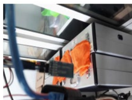
(d) Pemasangan bluetooth
