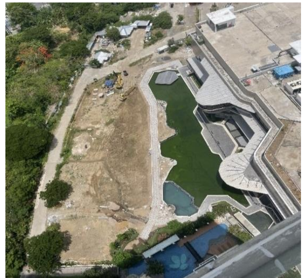
Gambar 1. Kondisi eksisting bangunan.
