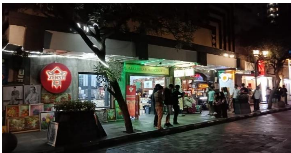
Gambar 2. Kondisi eksisting bangunan.
