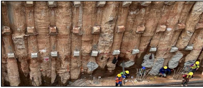
Gambar 1. Secant pile pada inlet proyek sodetan ke KBT.
