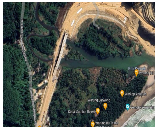
Gambar 1. Lokasi Pembangunan Jembatan Sine STA 0+325.
