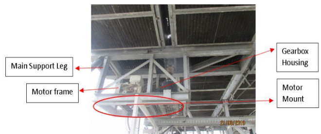
Gambar 1. Struktur rangka dudukan motor ( motor mount ) mesin pendingin
