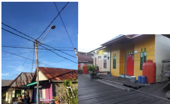
Gambar 9. Sarana dan prasarana di perkampungan nelayan
