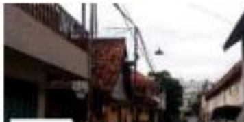
Gambar 5 Kondisi Tiang Listri Yang Berdekatan dengan Bangunan
