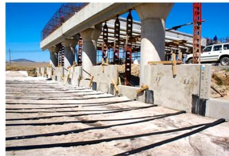
Gambar 14. Pemasangan Paraweb Straps
