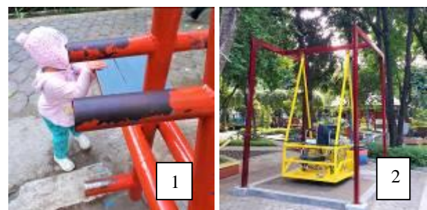
Gambar 8. Fasilitas bermain dengan cat mengelupas (kiri) dan fasilitas bermain untuk kelompok difabel (kanan).
