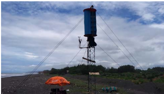
Gambar. 5. Turbin Savonius yang dipasang menjadi plant SKEA yang diletakkan di lokasi pengujian.
