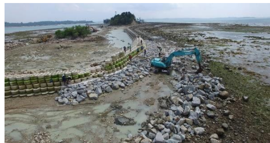
Gambar 1. Pemasangan buis beton sebagai seawall
