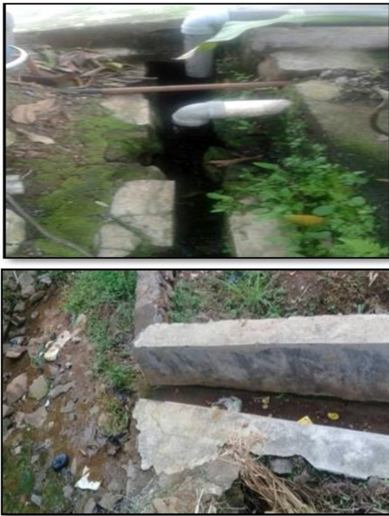
Gambar 1. Kondisi eksisting wilayah perencanaan.
