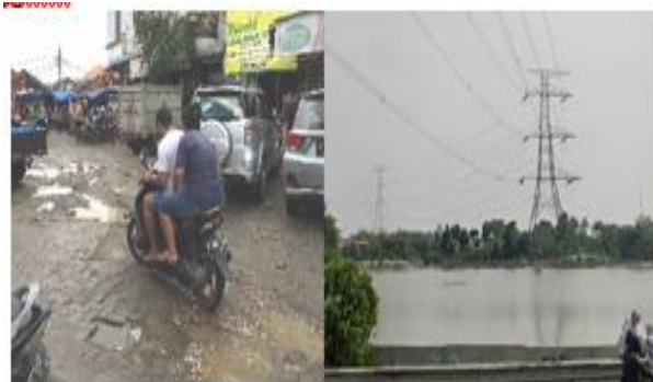
Gambar 4. Kondisi Eksisting Path dan Edge: (1) Jalan Lingkungan yang Rusak; (2) Situ Ciledug. Sumber: Survei Primer, 2020.
