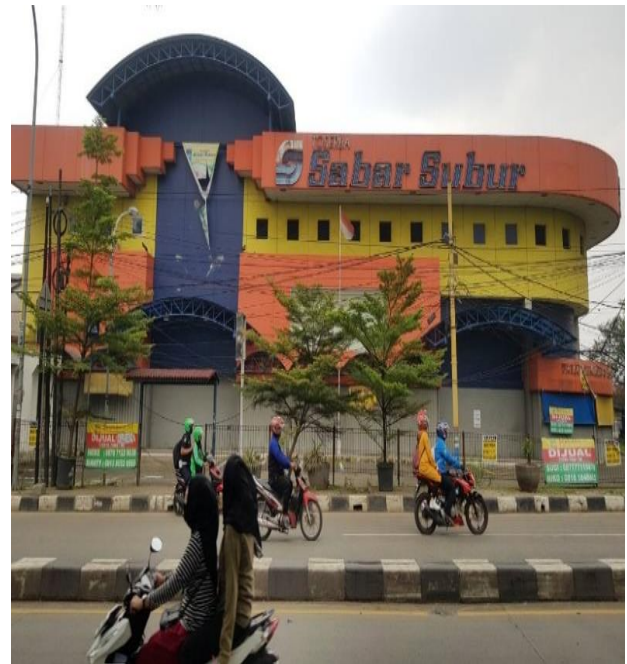
Gambar 1. Kondisi Eksisting Bangunan.
