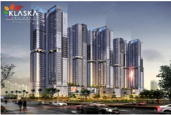
Gambar 1. Gambaran mengenai proyek Apartemen Klaska Residence Tower Azure Surabaya.
