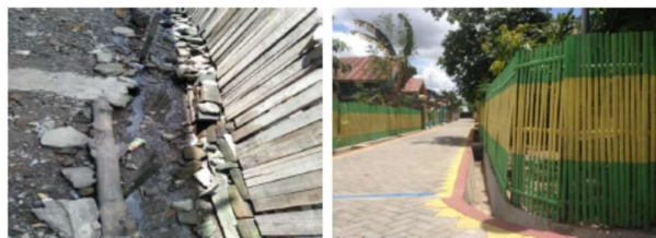
Gambar 6. Eksisting drainase dan strategi pembangunan drainase
