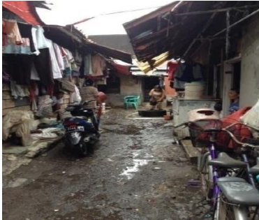
Gambar 2. Kondisi Fisik Bangunan di Permukiman Kumuh Sedang
