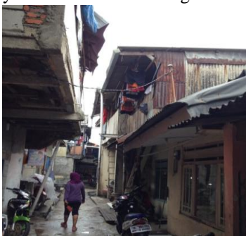
Gambar 1. Kondisi Fisik Bangunan di Permukiman Kumuh Ringan
