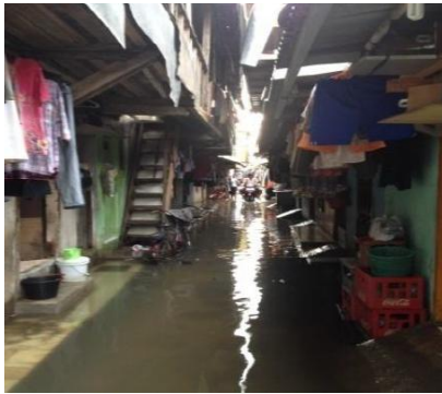
Gambar 3. Kondisi Fisik Bangunan di Permukiman Kumuh Berat
