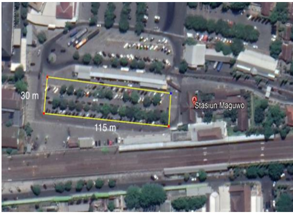
Gambar 2. Lokasi Park and Ride di Stasiun Maguwo, Yogyakarta.
