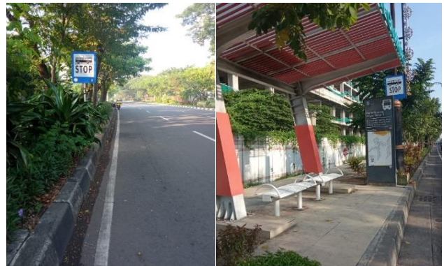
Gambar 3. Tempat Pemberhentian Bus dengan Kondisi Terburuk (kiri) dan Terbaik (kanan).
